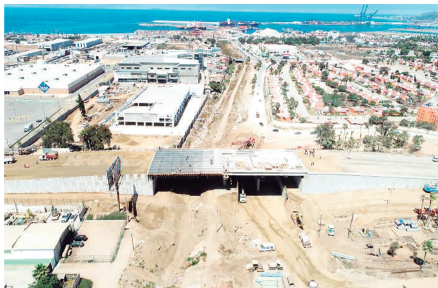
ENSENADA.- En recorrido por las obras en proceso del nodo vial El Gallo, el alcalde Armando Ayala Robles, constató importantes avances y fue informado que esta semana realizarán el primer colado de rodamiento.
