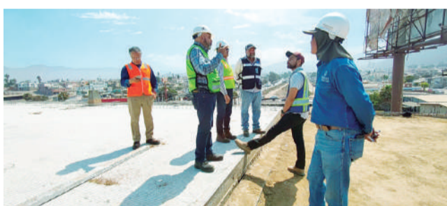
ENSENADA.- El secretario de la Sidurt del Estado, Arturo Espinoza Jaramillo, constató los avances en los trabajos del puente El Gallo, que será abierto a la circulación la próxima semana.
