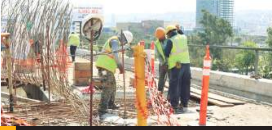
TIJUANA.- Especialistas de la SDTUA, junto con supervisores externos, analizan, reparan y construyen a detalle cada adecuación del Puente El Chaparral.
