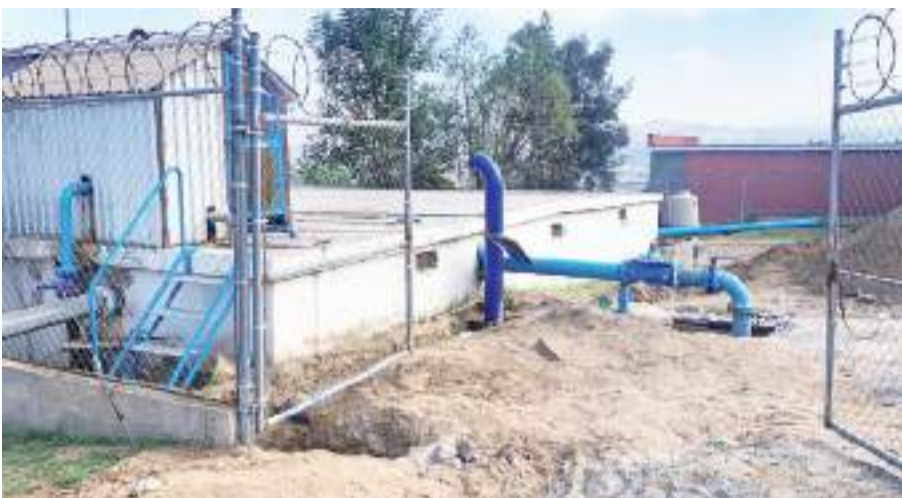
ENSENADA.- Debido a trabajos a realizar en la infraestructura hídrica de Valle Dorado y de la Márquez de León, será suspendido de manera temporal el abasto de agua en las colonias de ambas zonas de la ciudad.
