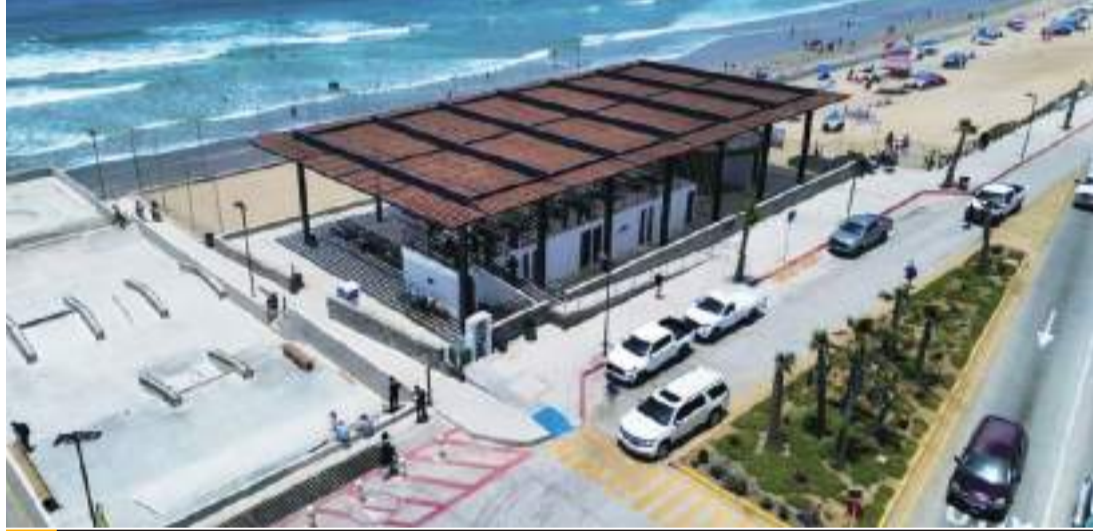
ENSENADA.- Supervisa el Alcalde Armando Ayala las obras de reforzamiento de la Sedatu en el malecón de Playa Hermosa que presentaban algunos detalles en su conclusión.
