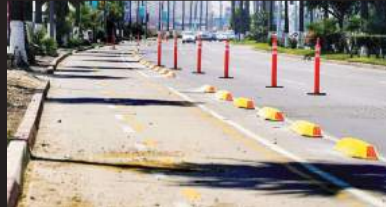
En la ruta de la Ciclovia se están colocando delimitadores tipo trapezoidal con reflejante, de 1.80 metros de largo con anclaje químico epóxico a 20 centímetros de profundidad.
