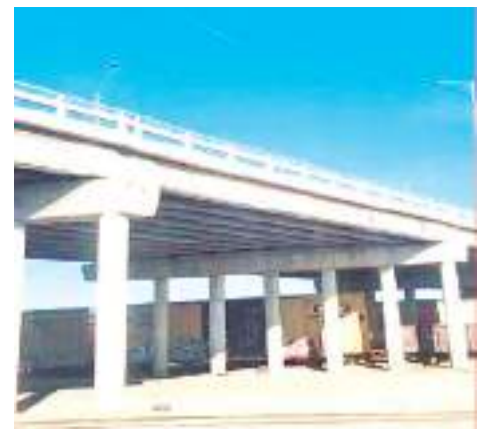
MEXICALI.- Sin riesgo para los automovilistas los puentes revisados por la empresa para su posterior rehabilitación.
