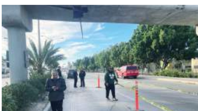
TIJUANA.- Permanecerá cerrado un carril de circulación por seguridad de los automovilistas y para la reparación segura de la infraestructura.
