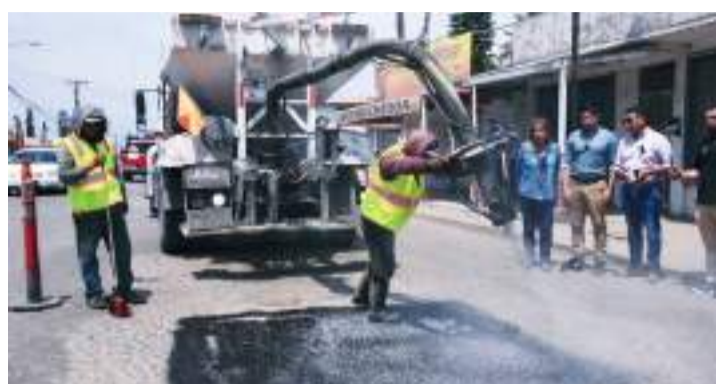
ENSENADA.- Realizará el Gobierno Municipal obras de pavimentación con concreto hidráulico en el vado de la avenida principal del ejido Chapultepec.
