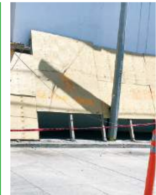
ENSENADA.- Personal de Protección Civil Municipal se encuentra trabajando para descartar daños estructurales.
