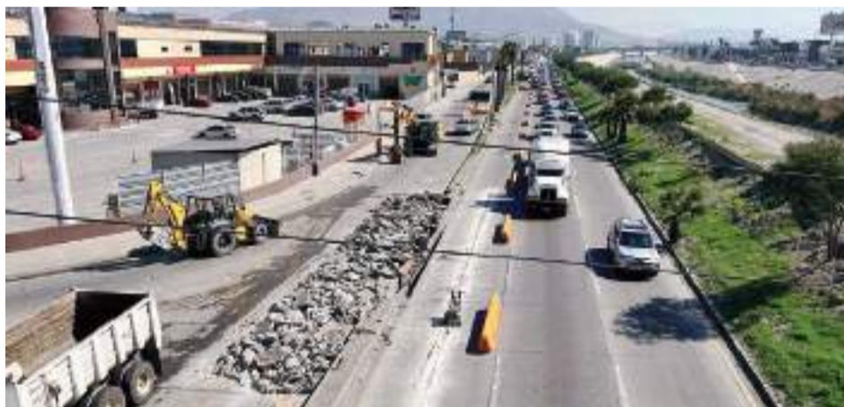
TIJUANA.- Hacen un llamado a la ciudadanía para circular con precaución en la zona, o bien, tomar vías alternas durante el tiempo que tardarán los trabajos de reparación.
