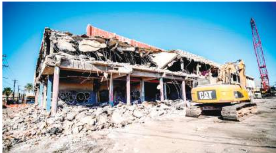
MEXICALI.- Después de varios años, inició la demolición del Mercado Municipal de Mexicali, todo un legado cultural.
