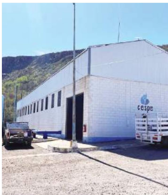
ENSENADA.- La CESPT concluyó trabajos de reparación en la planta de bombeo de La Misión.
