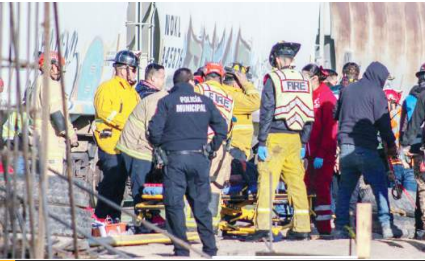
TIJUANA.- Cuatro trabajadores fueron víctimas de la negligencia en seguridad por parte de los ingenieros responsables de la construcción del Viaducto Elevado, tres presentaron lesiones graves en las piernas.
