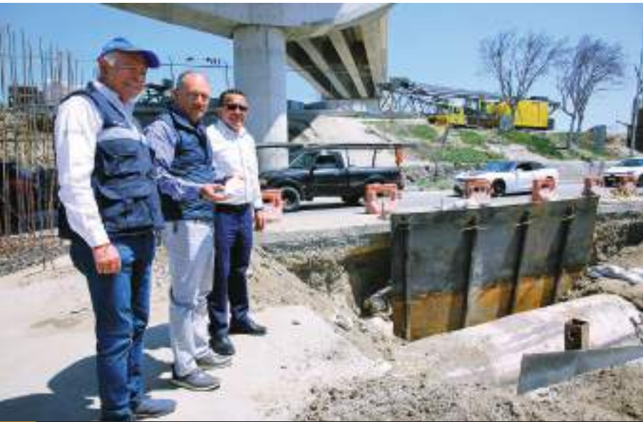
TIJUANA.- El director de la CESPT, Jesús García Castro, supervisó los avances del colector internacional, que cuenta con un 95% de progreso.
