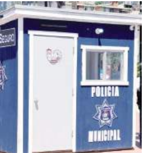
ENSENADA.- Se instaló una caseta de vigilancia en Zona Centro para atender reportes de inmediato.
