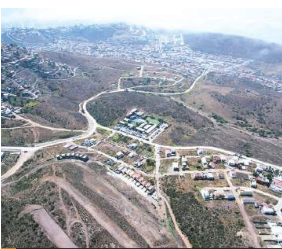
ENSENADA.- Se realizan trabajos de colado de guarniciones en avenida Bahía Asunción.
