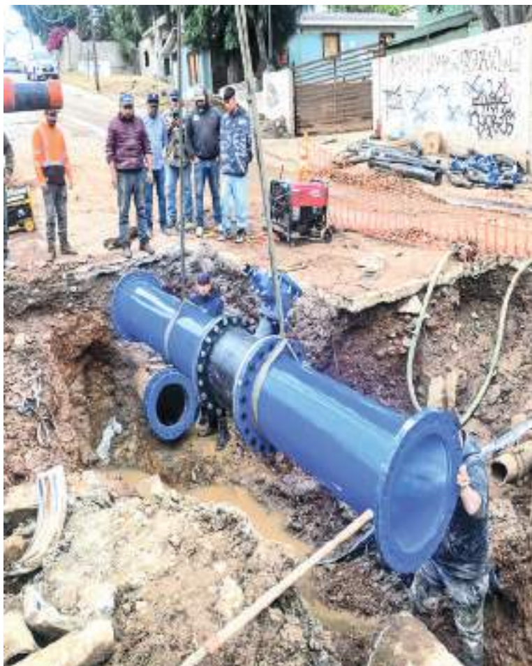
ENSENADA.- Personal de la Comisión de Servicios Públicos de Ensenada (CESPE), repuso una tubería en la colonia Loma Linda.
