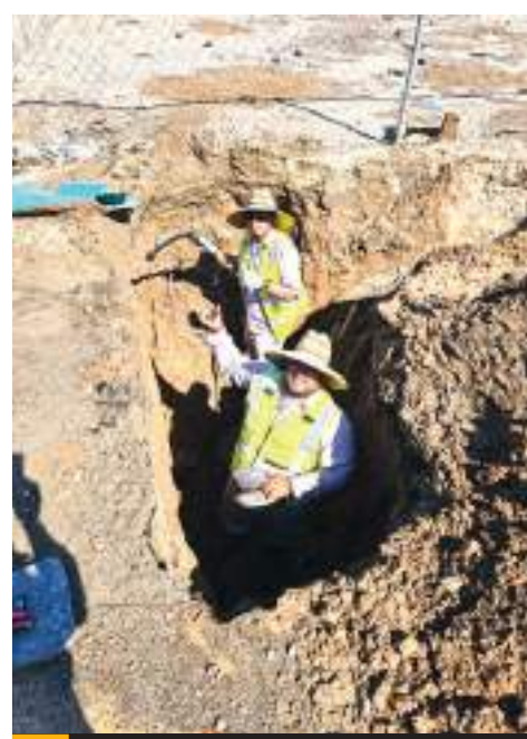
MEXICALI.- La CESPM avanza en el mantenimiento y mejora de infraestructura hidráulica en distintas instalaciones estratégicas del municipio de San Felipe.
