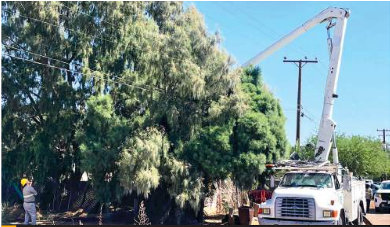
MEXICALI.- Se realiza una campaña intensiva de revisión de líneas y poda de árboles en diversas zonas de Mexicali para evitar fallas eléctricas.
