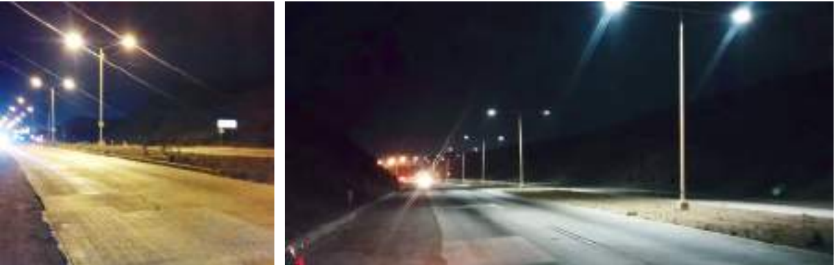
TIJUANA.- La SIDURT realiza trabajos de mejoras del alumbrado en el Corredor 2000.
