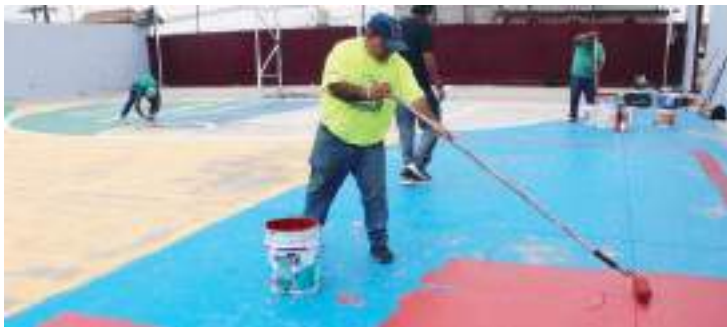
En la unidad deportiva de la colonia 17 de Abril destacan la rehabilitación y pintado de una pared, de la cancha y el rotulado de las áreas deportivas.
