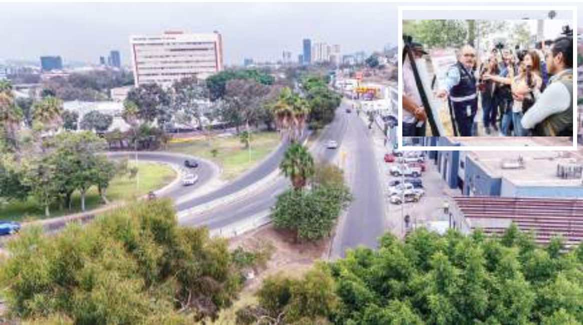
TIJUANA.- A partir de mañana lunes 21 de julio, se rehabilitará el Colector Oriente, del tramo Puente Negro-Hospital General, en boulevard Padre Kino en Zona Río.
