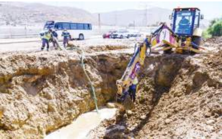
TIJUANA.- CESPT trabaja en la reparación de un acueducto a la altura del fraccionamiento Piedras Blancas en el bulevar 2000.
