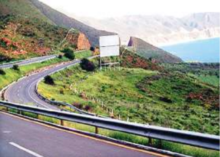
ENSENADA.- Del 11 al 13 de noviembre de 2025, se llevarán a cabo labores de bacheo profundo en autopista Ensenada-Tijuana.
