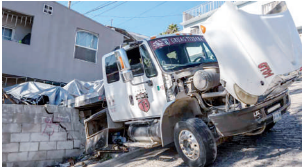
TIJUANA.- El chofer de la grúa y un habitante de la casa afectada, sufrieron lesiones tras el impacto; aunque ambos se encuentran fuera de peligro.
