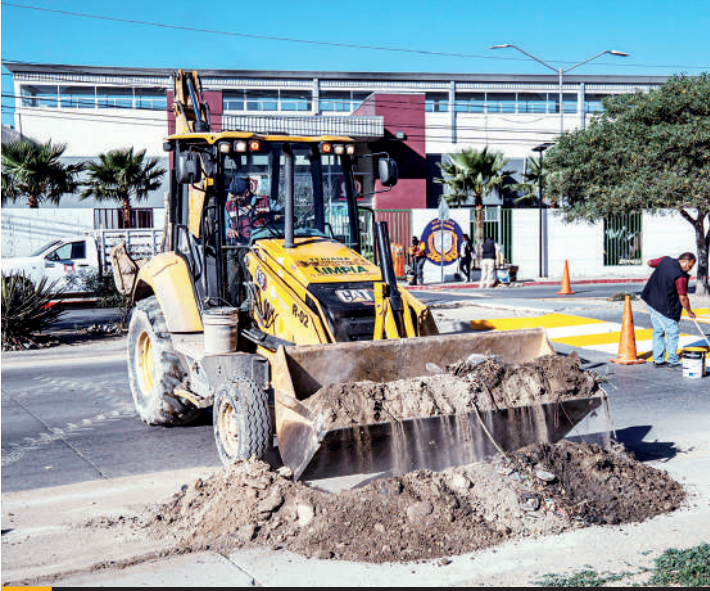
TIJUANA.- Acciones de mejoramiento urbano benefician a más de 14 mil personas en colonias de las delegaciones La Presa Este, La Presa Abelardo L. Rodríguez y Cerro Colorado.
