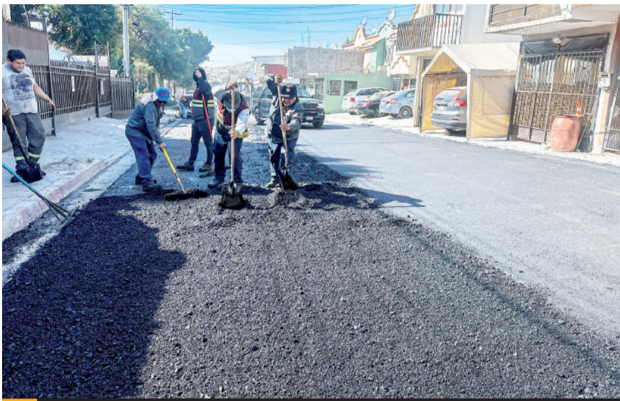
TIJUANA.- Cuadrillas del Gobierno Municipal realizan acciones de bacheo de trabajo en las delegaciones San Antonio de los Buenos, Centro, La Presa Este y Playas de Tijuana.
