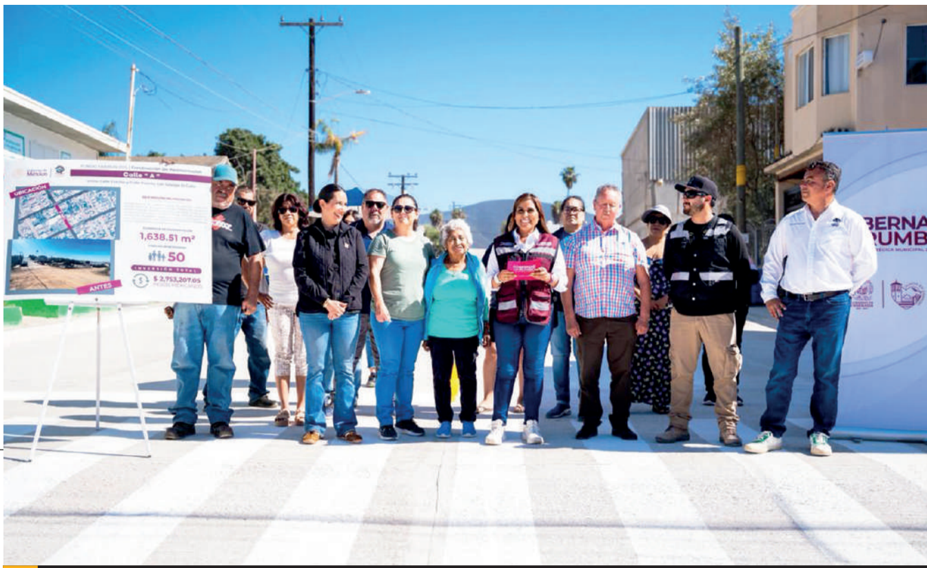
ENSENADA.- Con concreto hidráulico en la Calle A. en el Sector Oriente, se dio atención a las peticiones rezagadas de los residentes de dicha zona.
