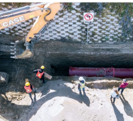
TIJUANA.- La directora de la CESPT, Mónica Vega Aguirre, informó que avanzan obras de saneamiento en esta ciudad.
