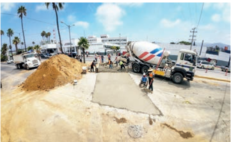
ENSENADA.- Se realizó el colado de la losa de concreto con acelerante.
