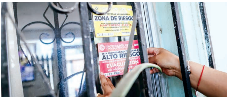
TIJUANA.- Las grietas en el bulevar Sánchez Taboada se acercan al cerro frente a la calle Eridano, donde comenzó el problema, derivado del movimiento continuo del terreno.
