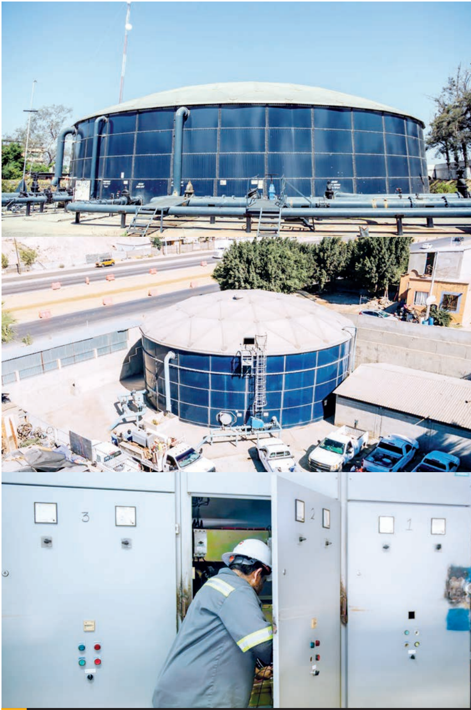
TIJUANA.- Equipos de bombeo de la CESPT se han mantenido fuera de servicio por falta de energía eléctrica, lo que ha provocado falta de agua en distintos sectores de la ciudad.
