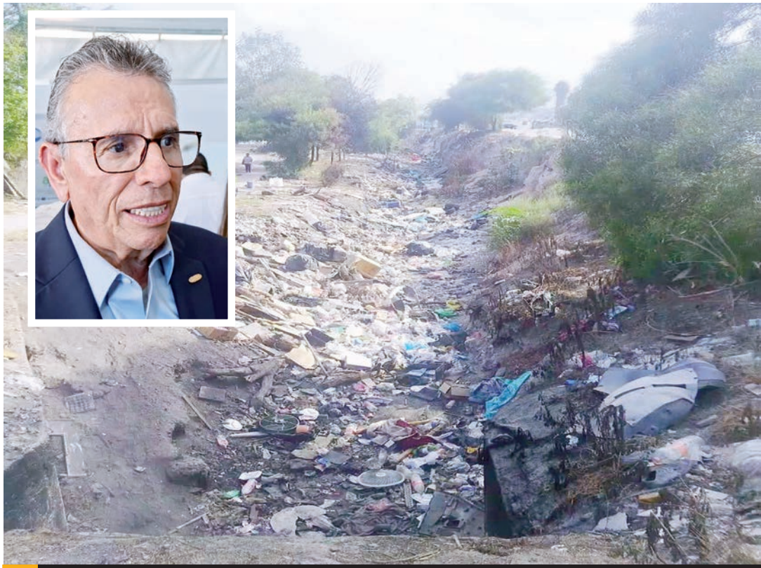
TIJUANA.-Expertos advierten sobre la importancia de mantener limpios los desarenadores y el cauce del río Tijuana previo a la temporada de precipitaciones.
