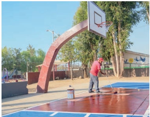
El Gobierno de Ensenada llevó a cabo trabajos de rehabilitación.
