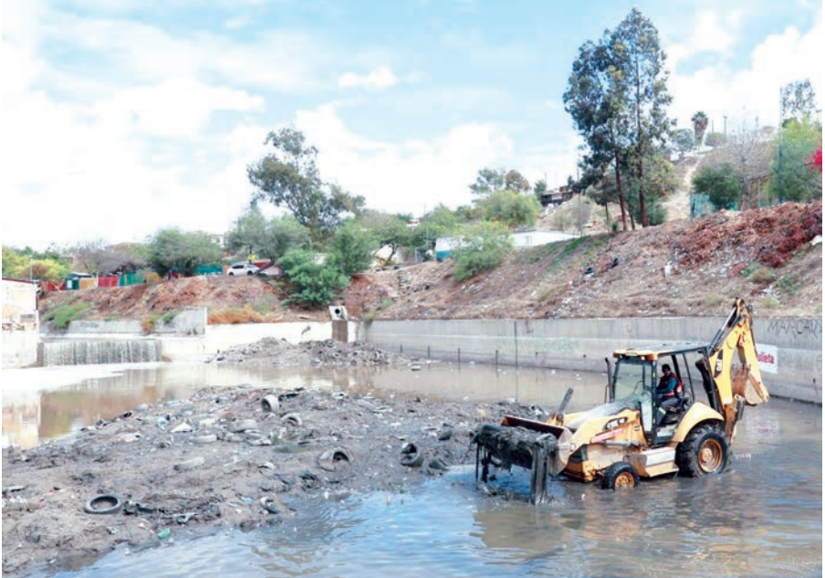
TIJUANA.- El presidente municipal, Ismael Burgueño Ruiz, realizó un recorrido de supervisión de los trabajos de limpieza y desazolve en el desarenador Florido 1.
