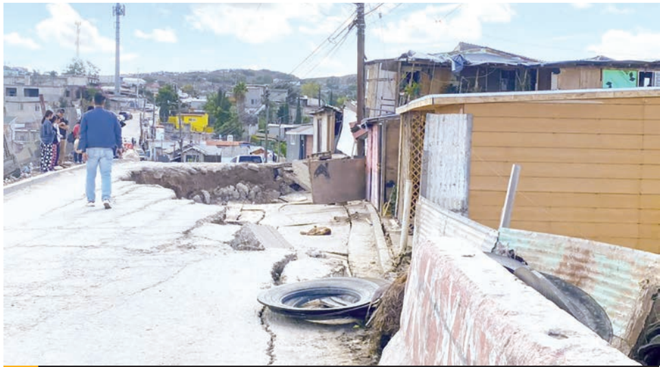
TIJUANA.- La calle Punta Arenas y varias de las casas ya presentan grietas considerables.
