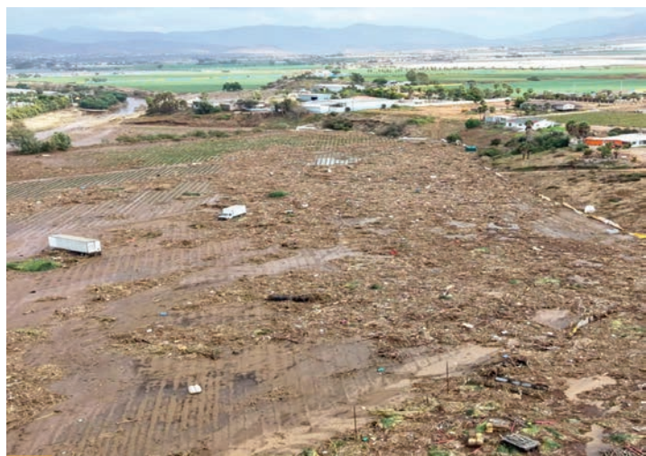
ENSENADA.- El arroyo cuenta con 4 ductos (tubos) para el paso del agua y actualmente sólo uno está funcionando.
